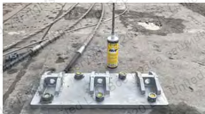
Установка опорной плиты узла натяжения дорожного фронтального ограждения
