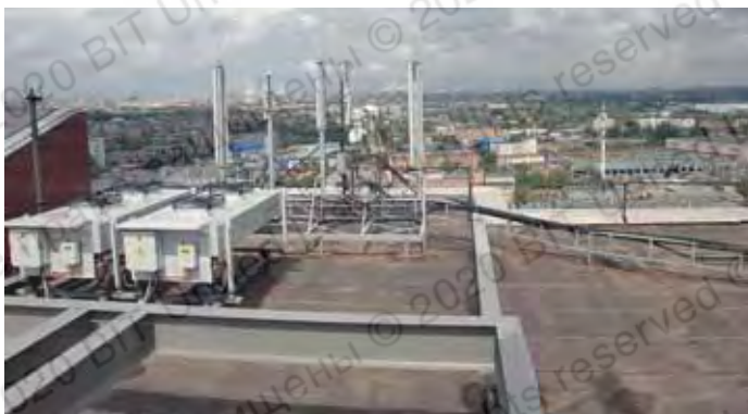
Крепление опорной рамы и растяжек антенно-мачтового сооружения сотовой связи на крыше здания (высокие требования к сохранению герметичности кровли и климатическим воздействиям)
