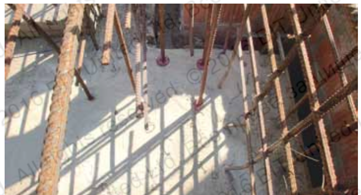
Увеличение частоты армирования с целью повышения несущей способности каркаса здания (корректировка проектного решения в процессе строительства)
