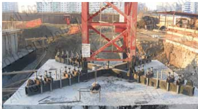
Монтаж опорной рамы башенного крана к фундаментной плите (Краснодарский край, г. Туапсе, 2014 г.)
