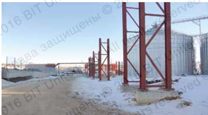
Крепление опор теплотрассы и газовой эстакады к фундаментным бетонным блокам (производство работ условиях строительной площадки в зимний период)
