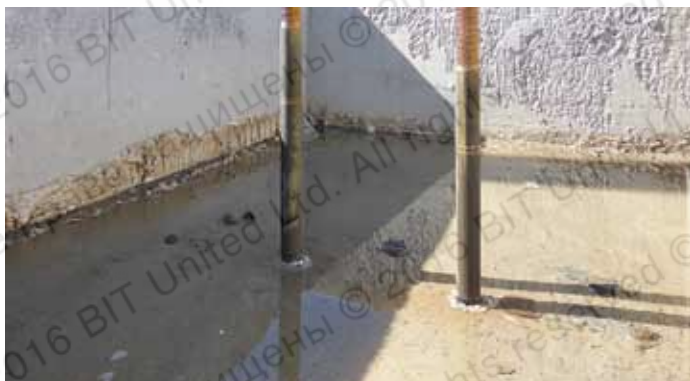
Установка химических анкеров в водонасыщенный бетон и в отверстия заполненные водой не оказывает влияния на несущую способность анкерного крепления
