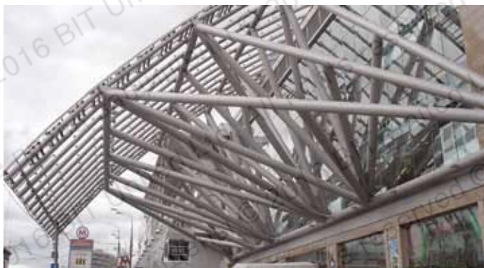
Пространственная конструкция козырька из круглой трубы (общий вес 162 тонны)
