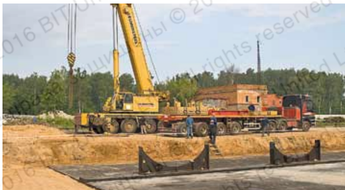
Монтаж ложементов резервуаров для хранения сжиженного газа (Московская область, г. Климовск, 2008 г.)
