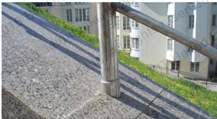
Монтаж лестничных ограждений в конструкции парапета, облицованного натуральным камнем
