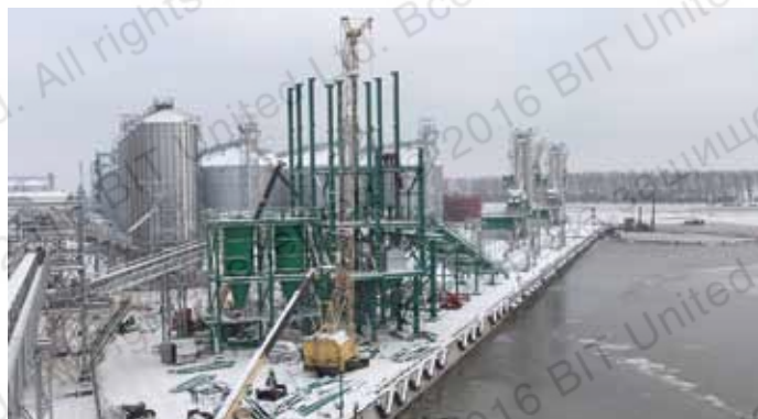
Монтаж металлоконструкций, силосов и элеваторов в зимний период (Маслоэкстракционный завод «Содружество-Соя», Калининградская область, г. Светлый, 2012 г.)
