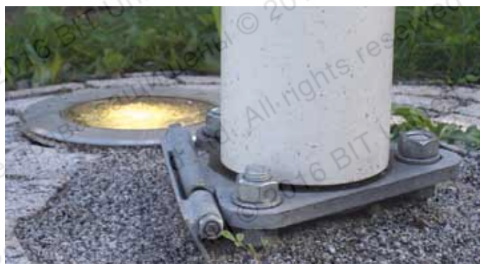
Крепление металлического флажстика к основанию из природного камня
