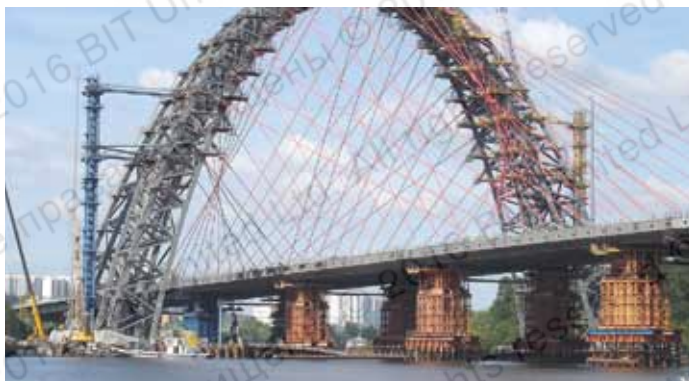
Крепление ограждающих конструкций правобережной эстакады вантово-пилонного моста (г. Москва, 2007 г.)
