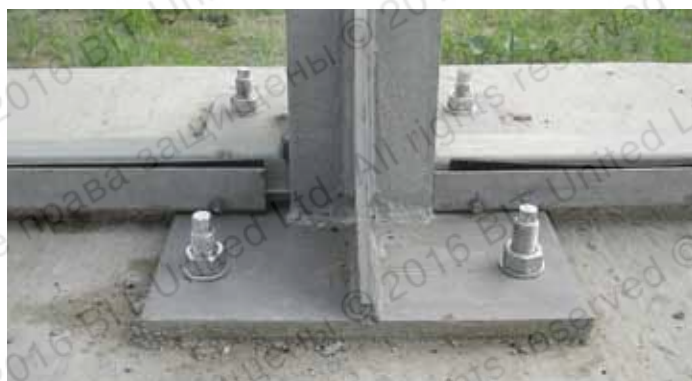
Применение анкер-шпильки из упрочненной стали при динамических воздействиях (крепление стоек шумозащитных экранов)
