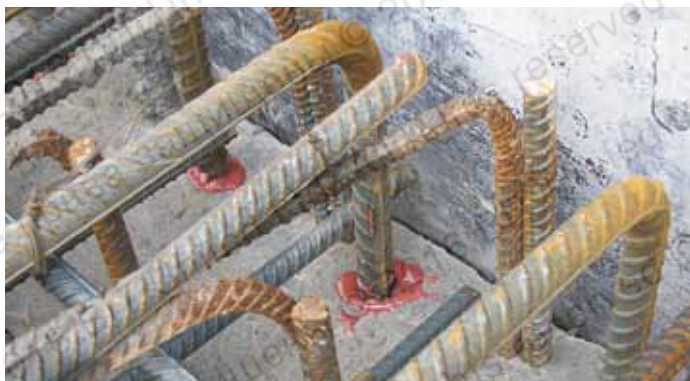
Увеличение количества арматурных стержней в соответствии с расчетом (СНиП 52-01-2003)
