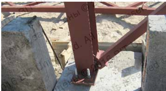
Установка металлических опор металлоконструкций (минимальное расстояние между осями креплений)
