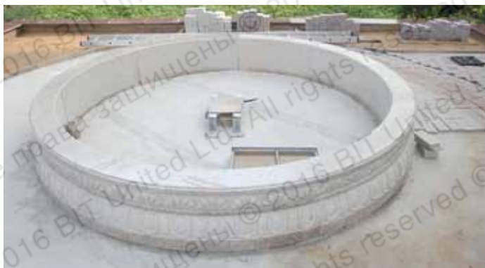
Соединение конструктивных элементов и монтаж облицовки фонтана выполненных из природного камня
