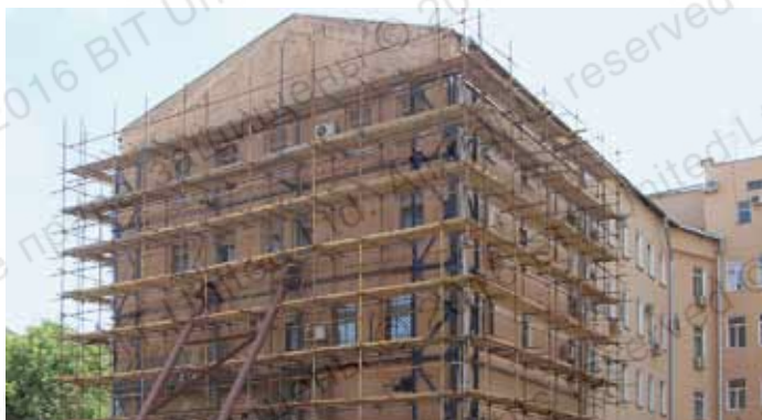
Усиление и обвязка существующего здания, расположенного в зоне устройства котлована при новом строительстве с многоярусной установкой анкеров с шагом 1000 мм по периметру здания (г. Москва, 2007 г.)
