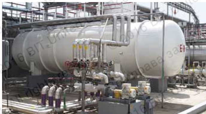
Исключительно высокая устойчивостью к агрессивным средам, кислотам и щелочам при монтаже оборудования на нефтехимических предприятиях
