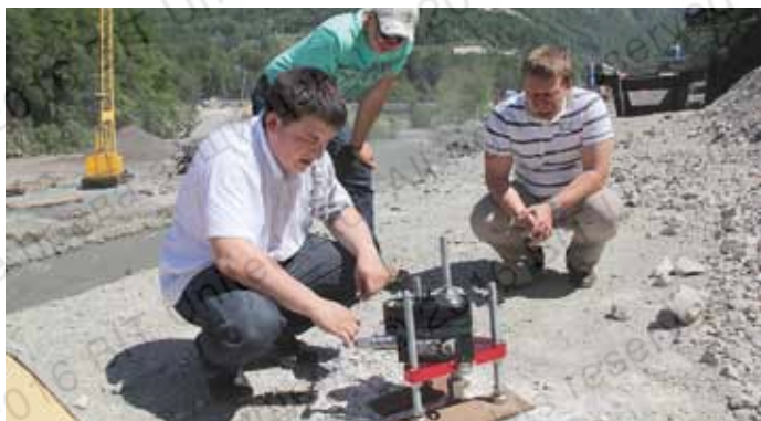
Испытания крепления противокамнепадного ограждения к горной породе (совмещенная автомобильная и железная дорога Адлер — горно-климатический курорт «Альпика-Сервис», пос. Красная Поляна, 2013 г.)
