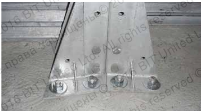
Узел крепления стоек барьерного ограждения к мостовому полотну: диаметр шпильки М24, глубина заделки L=300 мм (удерживающая способность ограждения мостовой группы 400 кДж)
