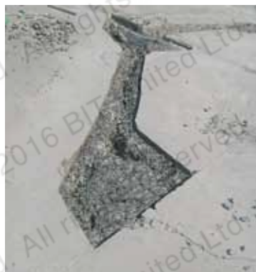
Самовыравнивание смеси при заливке пустот, широких трещин и труднодоступных зон
