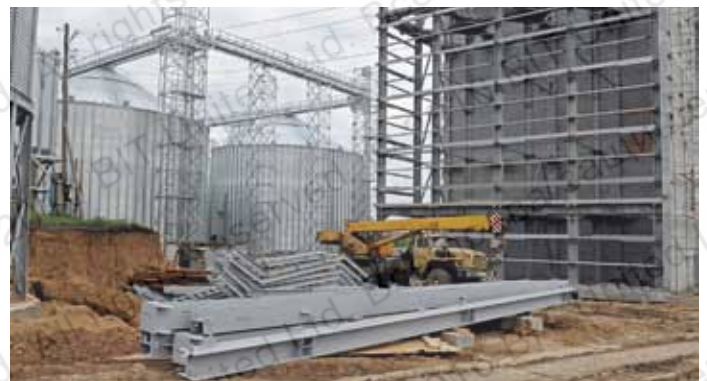
Крепление металлоконструкций и силосов при строительстве завода премиксов №1 (Центр Инновационных Биотехнологий, Белгородская область, 2014 г.)
