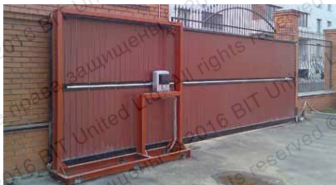
Крепление механизмов и конструкций откатных ворот к кладке из пустотелого кирпича (применение в сочетании с сетчатыми гильзами)
