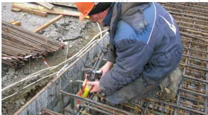
Дополнительное армирование железобетонной плиты перекрытия (Строительство подземного паркинга, г. Екатеринбург, 2012 г.)
