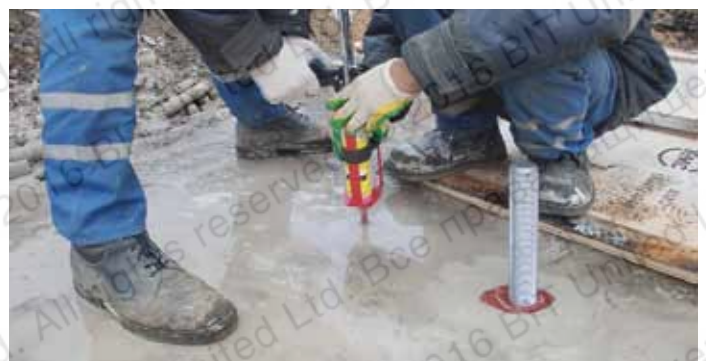
Установка анкеров в отверстия выполненные с применением технологии алмазного бурения (отверстия полностью заполнены водой)
