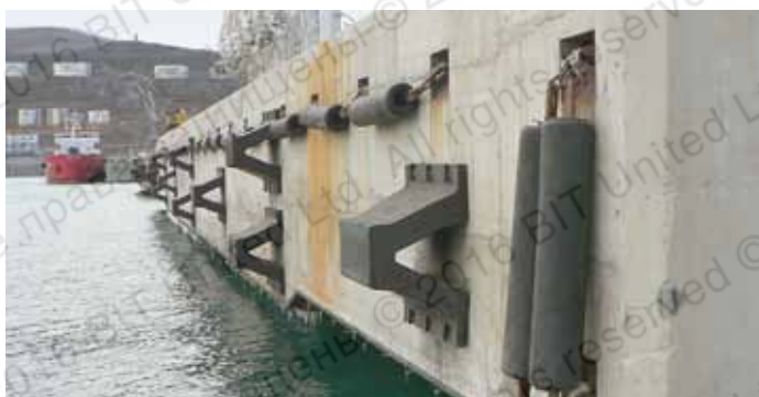
Монтаж причально-отбойных приспособлений для нефтеналивных танкеров под высокие динамические нагрузки (реконструкция нефтеналивного терминала РОСНЕФТЬ, г. Находка, 2009 г.)
