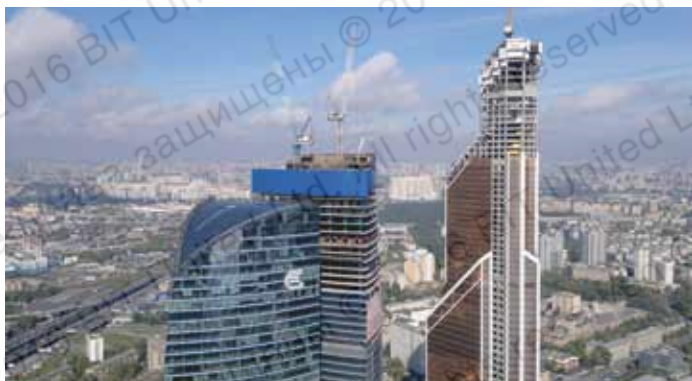
Монтаж металлоконструкций и лифтового оборудования (Высотный комплекс «Москва-Сити», Москва, 2010–2015 гг.)
