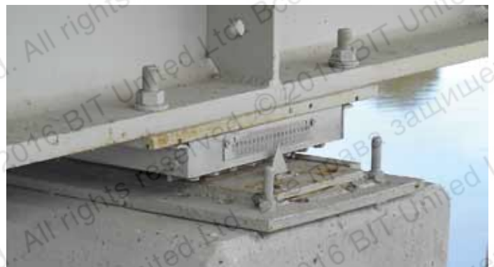
Крепление индикатора линейного перемещения вантового моста (минимальное расстояние от края)
