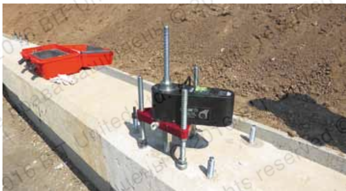
Испытание анкерных элементов креплений стоек шумозащитных экранов (анкер-шпилька ВIT-SS M24×300, расчетная нагрузка на вырыв 82,9 кН)
