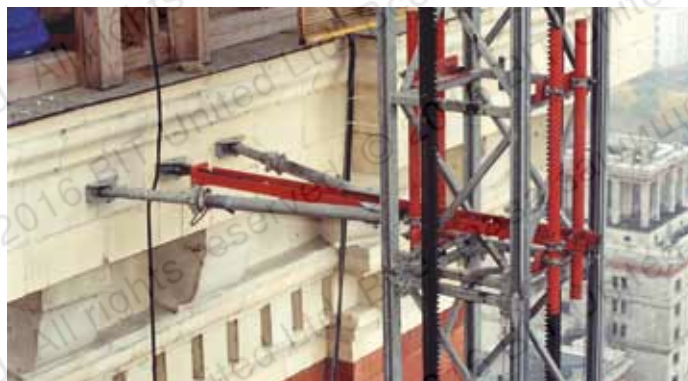
Особо ответственные крепления под высокие нагрузки в труднодоступных местах (крепление строительного подъемника к высотному зданию «сталинской» постройки)
