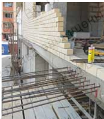
Наращивание железобетонных плит балконов и лоджий (исправление ошибок производства монолитных работ)
