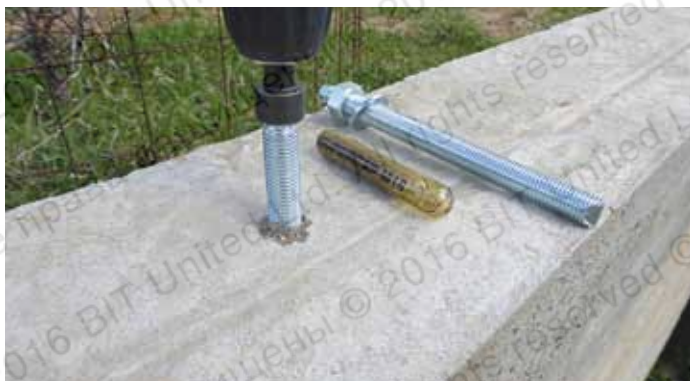
Установка анкер-шпильки BIT-SS 16 x 190 с торцевым шестигранником в бетонный ленточный фундамент (применение специального адаптера для перфоратора)
