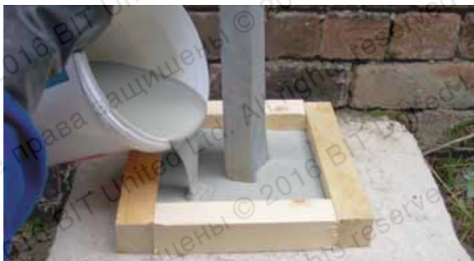
Высокоточная подливка оснований фундаментов
