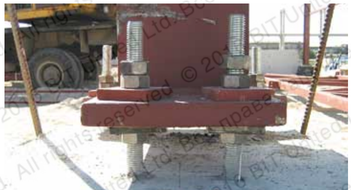
Монтаж металлической колонны к железобетонному основанию (резьбовая шпилька M24, максимальная нагрузка на вырыв 128,5 кН)
