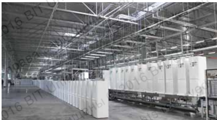
Монтаж конвейерной линии по производству крупногабаритной бытовой техники LG (Завод LG Electronics, Московская область, пос. Дорохово, 2010 г.)
