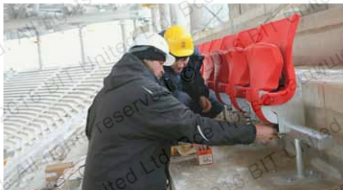
Монтаж кресел и ограждений (стадион «Открытие Арена — Спартак», г. Москва, 2014 г.)
