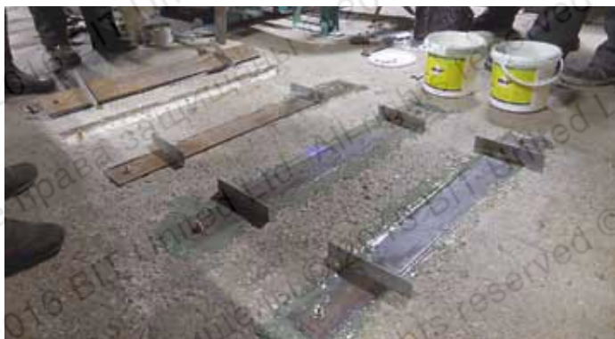
Усиление железобетонной плиты перекрытия складского комплекса (ЗАО «Агрокомбинат Московский», г. Московский, 2016 г.)
