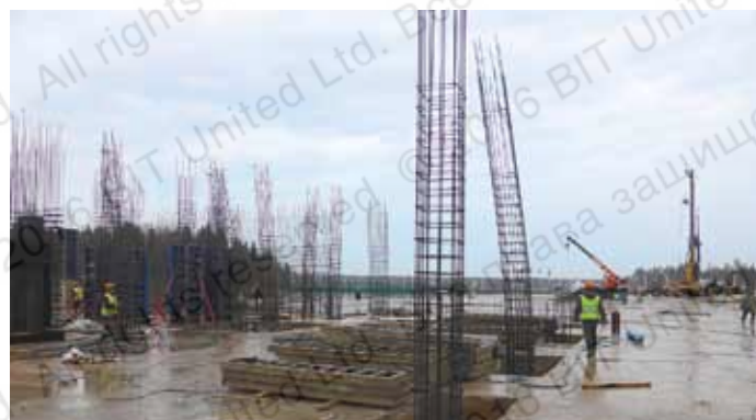
Вклейка арматурных каркасов при полномасштабной переработке проекта в процессе строительства (Военно-патриотический парк культуры и отдыха ВС РФ «Патриот», Московская область, г. Кубинка, 2016 г.)
