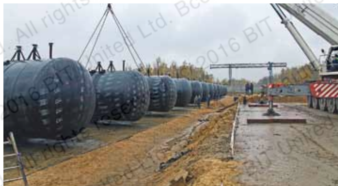
Установка резервуаров для хранения сжиженного газа в проектное положение (вес изделия 44 тонны)
