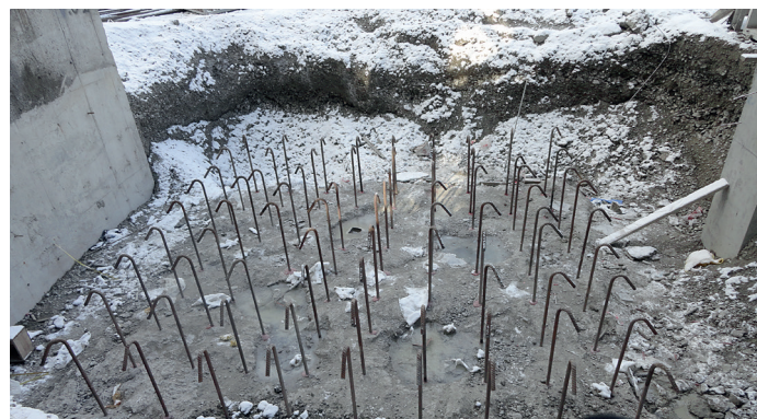
Устройство арматурных выпусков при увеличении толщины фундаментной плиты: арматура d=36 мм, глубина заделки L=1000 мм (завод по производству цемента, г. Новороссийск, 2012 г.)
