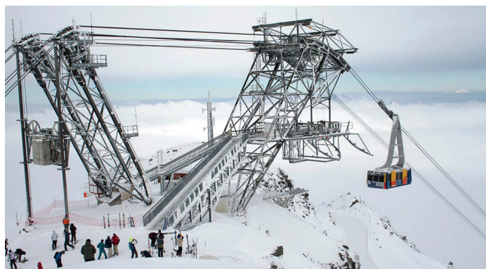
Крепление горнолыжных подъемников, фуникулеров и подъемно-транспортных устройств непосредственно к горной породе в условиях постоянных отрицательных температур
